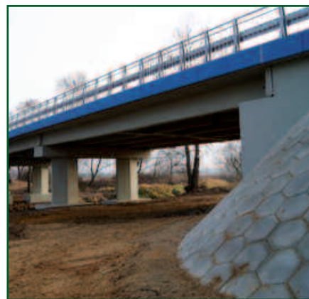
Most w Rudniku po przebudowie
