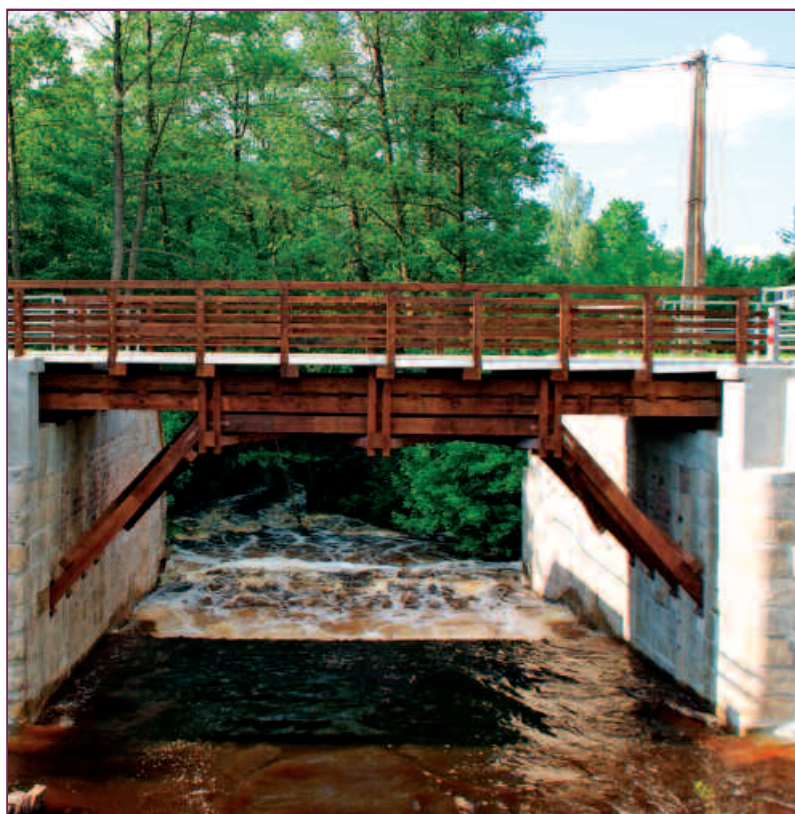
Wyremontowany przepust staszycowski
