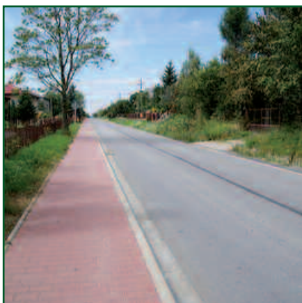
Przebudowana droga powiatowa 0598T
