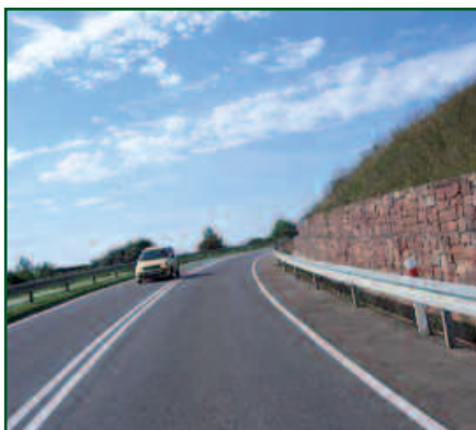
Nowa droga nad zalew Wióry
