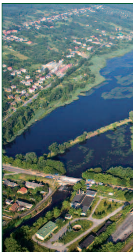
Układ wodny - zapora na rzece Kamiennej
