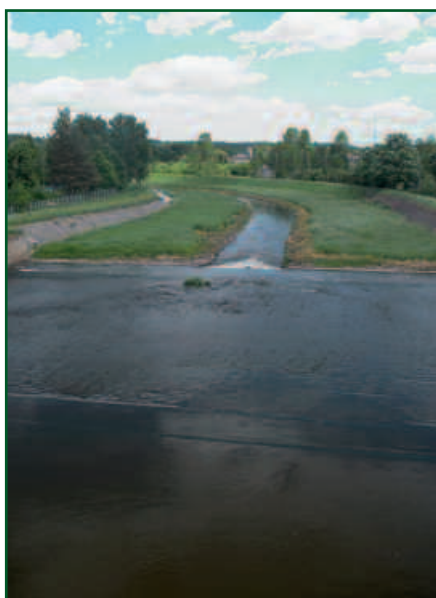
Przepust wodny na Kamiennej
