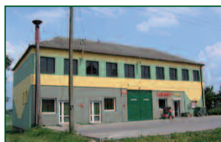
Odnowiony budynek OSP Brzezcie
