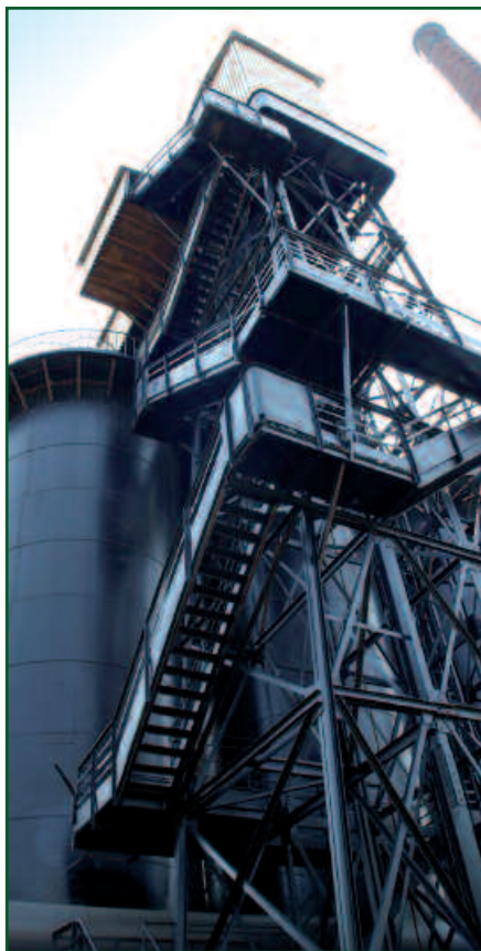
Wielki piec - kratownica windy gichtowej
