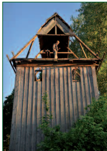
Remont zabytkowej dzwonnicy w Tarczku
