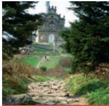
Droga Królewska z Nowej Słupi, fot. M. Jurecki
