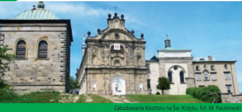
Zabudowania klasztoru na Św. Krzyżu, fot. M. Paszkowski
