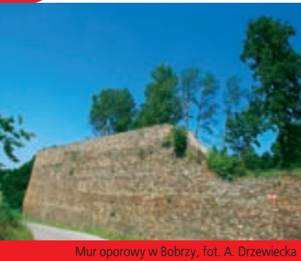
Mur oporowy w Bobrzy, fot. A. Drzewiecka
